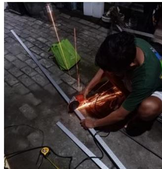
Gambar 10 pemotongan gavalum
